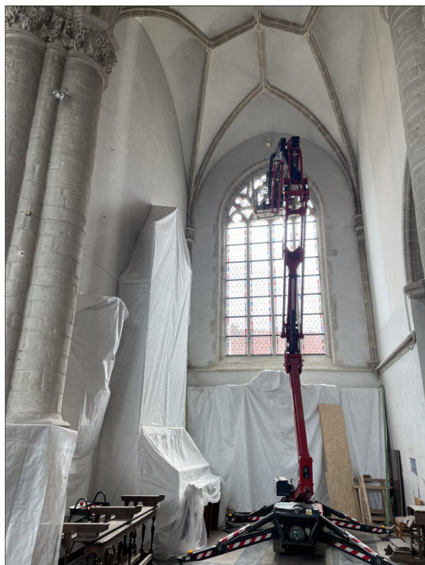
De hoogwerker neemt de bescherpanelen voor de ramen weg
