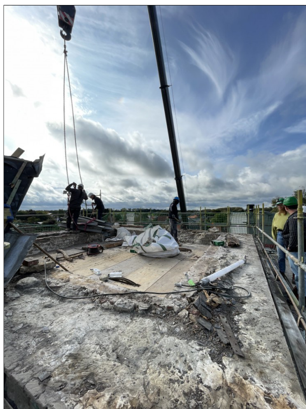
De torenromp wordt ingepakt met krimpfolie
