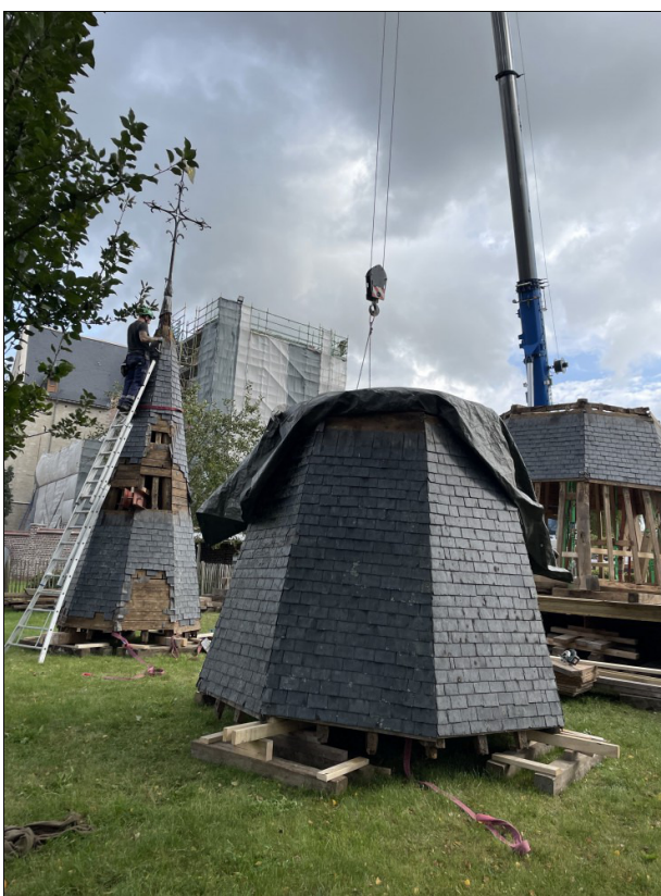
De drie torenelementen op het grasveld voor restauratie
